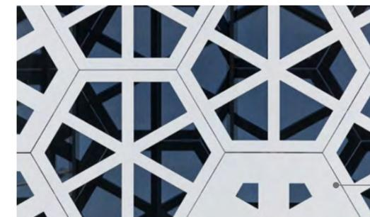
La technologie moderne de fraisage CNC a permis de concevoir chaque élément de façade individuellement ; le joint de dilatation – un élément obligatoire de la façade – est transformé en un remarquable élément de design.
