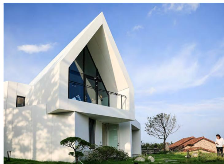
Avec son aspect simple en apparence, cette maison a été en réalité un véritable défi pour les architectes et les fabricants : ses cubes qui s'emboîtent (certains avec des surfaces sans joints apparents, d'autres avec des lignes de démarcation) sont tous fabriqués en HIMACS.
