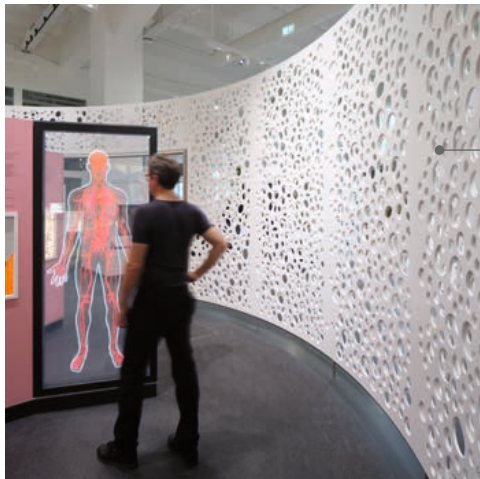
Différents designs de haute précision ont été usinés dans le matériau par des fraiseuses CNC
