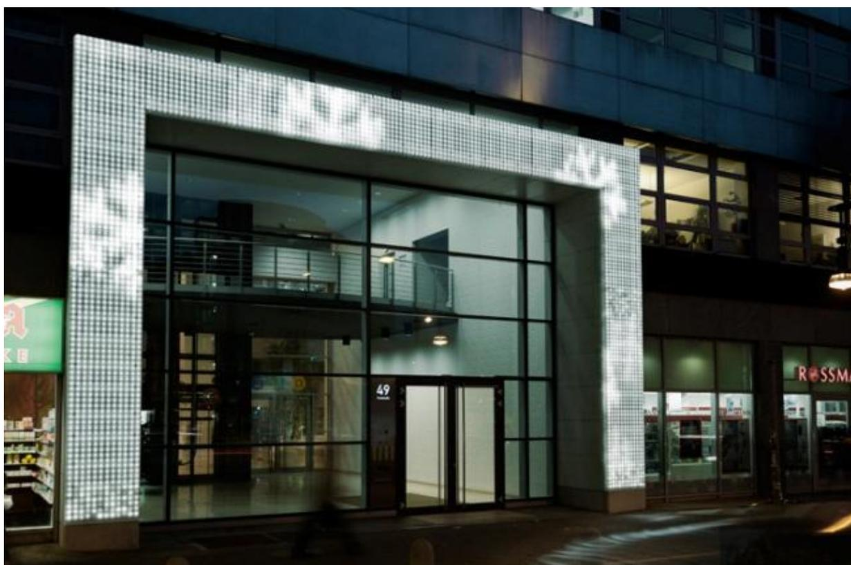
La particolarità dell'arco del portale in HI-MACS® è la traslucenza del materiale. Si tratta di pietra acrilica nella tonalità Opal. Le lastre vengono retroilluminate a LED, permettendo così la riproduzione di figure, caratteri e simboli in movimento come grafica raster.
